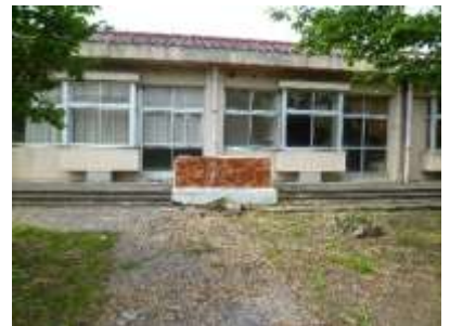
保育室の外壁
