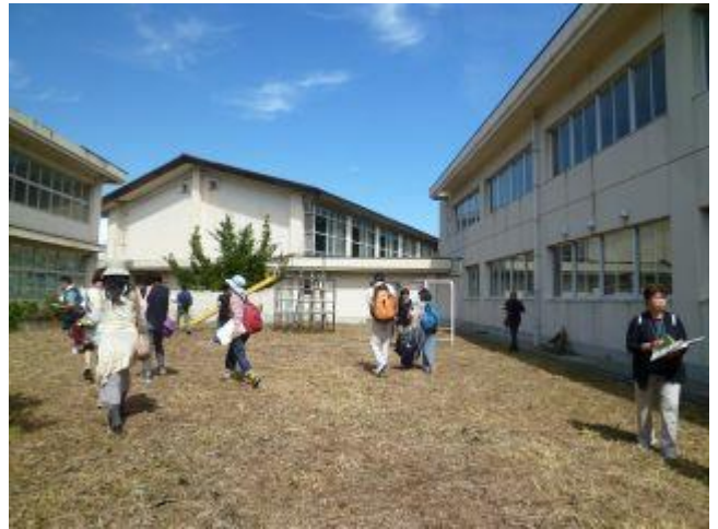
小学校部分と中学校部分に挟まれた中庭
